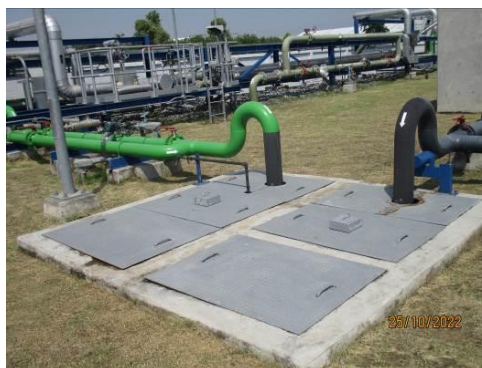
ภาพที่ 2.2-12 วาล์วควบคุมการปล่อยน้ำทิ้งจากหอหล่อเย็น
