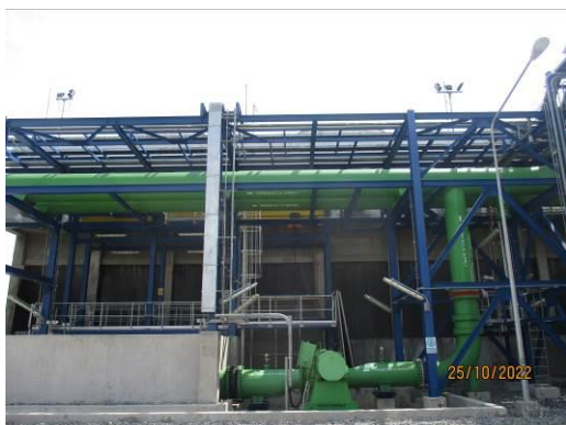
ภาพที่ 2.1-1 หอหล่อเย็น (Cooling Tower)
