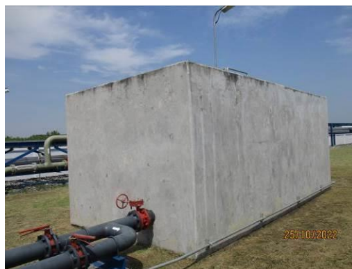
ภาพที่ 2.2-16 บ่อแยกน้ำ/น้ำมัน (Oil Separator)
