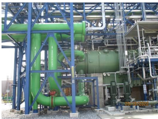
ภาพที่ 2.2-15 เครื่องควบแน่น (Condenser)
