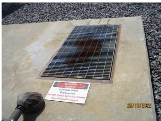
ภาพที่ 2.2-21 บ่อปรับสภาพความเป็นกรด-ด่าง (Neutralization Pit)
