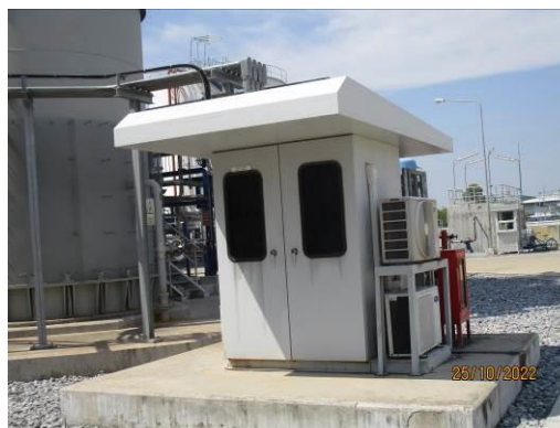
ภาพที่ 2.2-2 ระบบ CEMs ของ ปล่อง HRSG 11 และปล่อง HRSG 12
