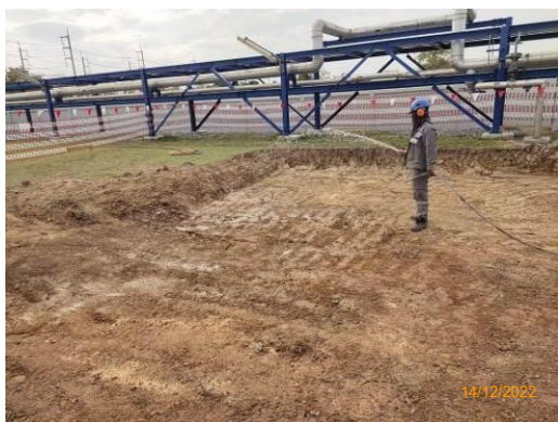
ภาพที่ 2.1-3 การฉีดพรมน้ำในพื้นที่ก่อสร้าง
