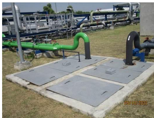
ภาพที่ 2.2-18 ท่อระบายน้ำทิ้งจากบ่อพักน้ำทิ้งรวมไปยัง ระบบบำบัดน้ำเสียส่วนกลางของนิคมฯ
