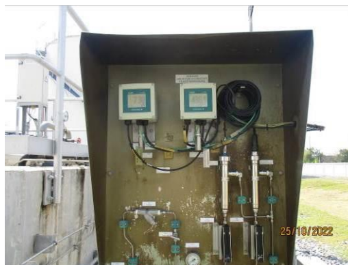
ภาพที่ 2.2-22 ระบบ Online Monitoring บริเวณบ่อพักน้ำทิ้งรวม
