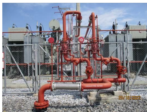
ภาพที่ 2.2-38 ระบบป้องกันเพลิงไหม้และระบบดับเพลิงของโครงการฯ
