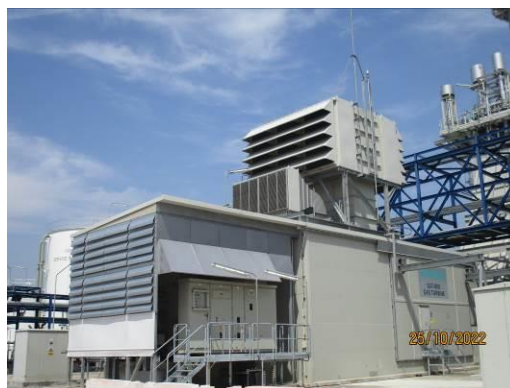
ภาพที่ 2.2-6 อาคารคลุมเครื่องจักร (Enclosure)
