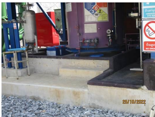
ภาพที่ 2.2-45 คันกั้นสารเคมีหกรั่วไหล
