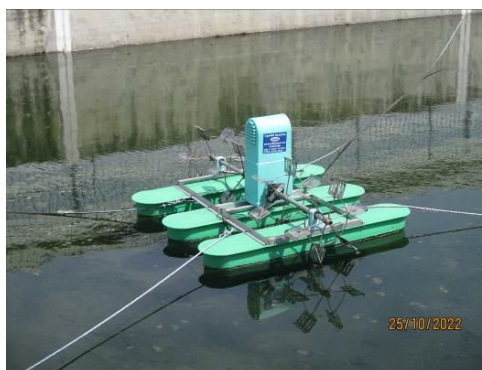
ภาพที่ 2.2-14 เครื่องเติมอากาศในบ่อ CT Blowdown
